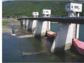
阿賀野川頭首工
