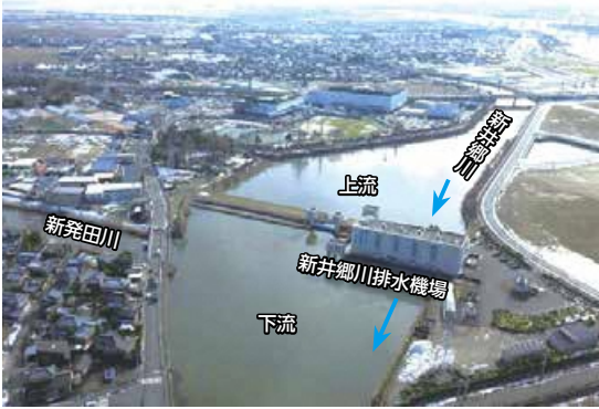
写真2 新井郷川排水機場
