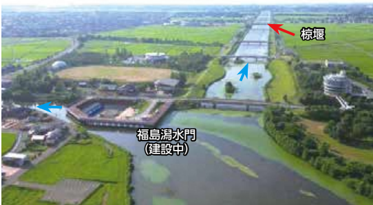
写真1 福島潟放水路(入り口付近から下流を望む)
