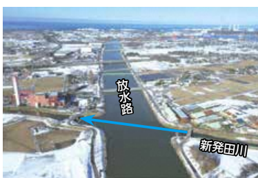
写真11 直交する新発田川 新井郷川排水機場下手とつながる
